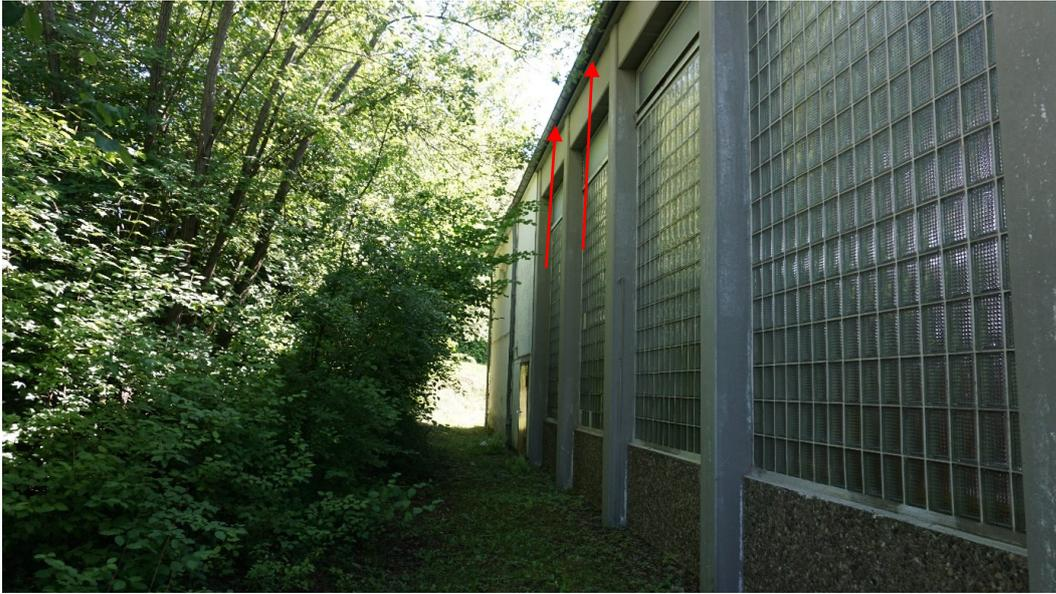
Abbildung 6: Nordwestseite, Gehölze und Spalten hinter Dachverblendung
