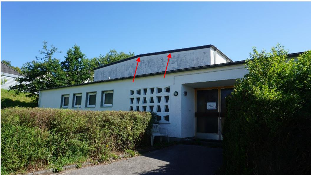
Abbildung 7: Südwestseite, Hecken und Spalten hinter Schieferverblendung des Dachs
