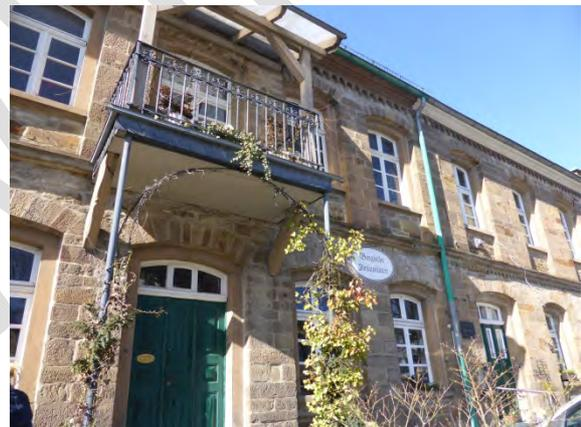
Abbildung 35 Kombination Bergischer Schiefer und Fachwerk als Fassade und Grauwacke als Sockel
