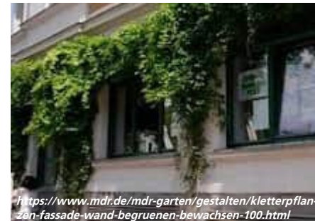
Beispiel partielle Fassadenbegrünung
