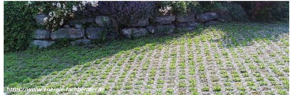
Versickerungsoffene Verkehrsflächen rund ums Haus
