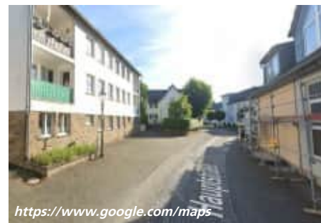
Einmündung Mühlenseite im Osten
