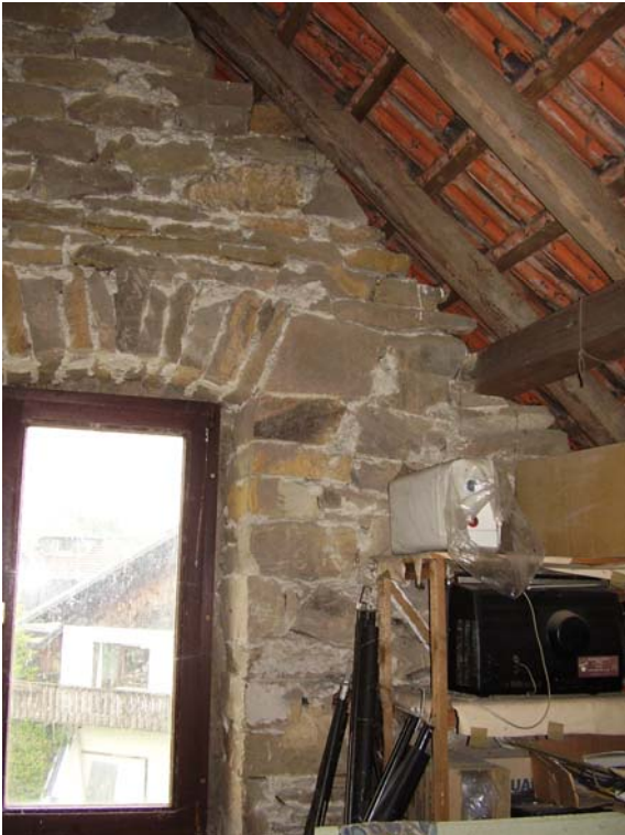
Foto – Ansicht der vorhandenen Übergänge Dach/Wand:
