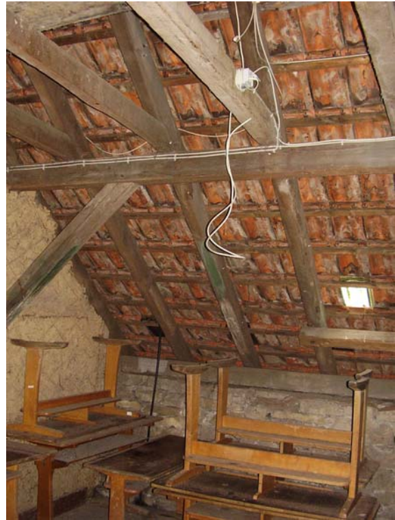
Foto – Ansicht der vorhandenen Dachuntersicht/Drempelbereich:
