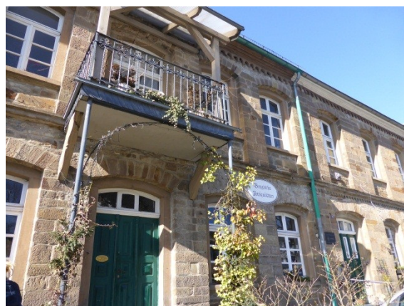
Abbildung 34: Fassaden aus Grauwacke
