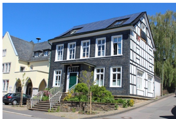
Abbildung 35 Kombination Bergischer Schiefer und Fachwerk als Fassade und Grauwacke als Sockel
